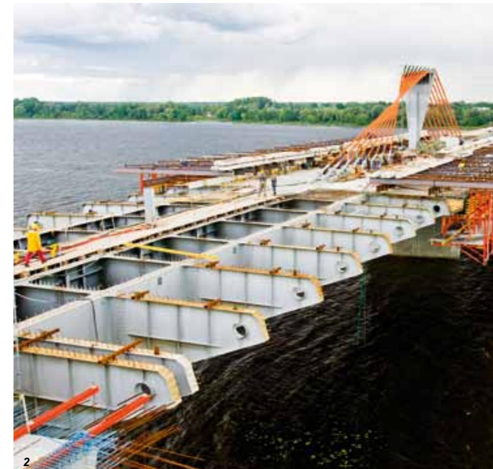
2. Монтаж металлоконструкций Южного моста, Рига, Латвия
