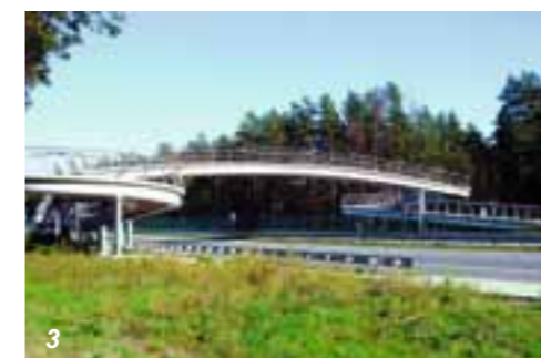
4. Строительство путепровода, Туркменбаши, Туркменистан
